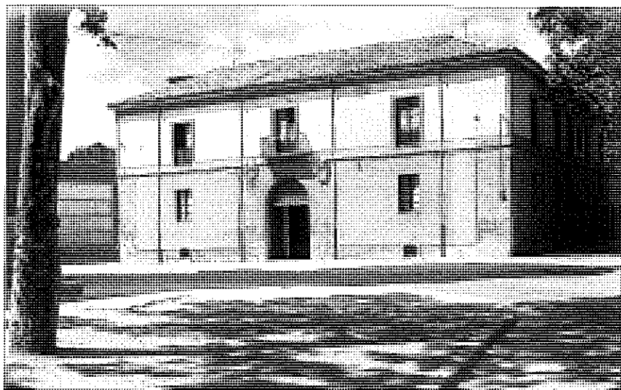
Casa de los capellanes de la Magdalena situada enfrente de la iglesia (h. 1950). Valladolid.
